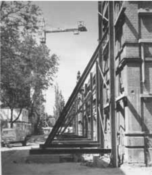
Abb. 6: Fassadensicherung im Giebelbereich
