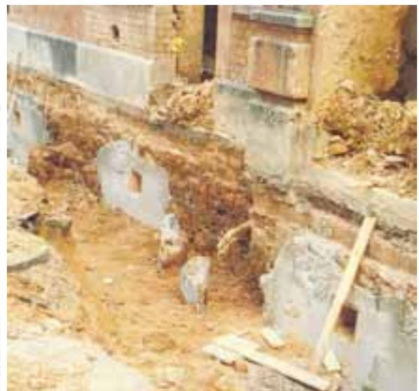
Abb. 5: Nachgründung mittels Unterfangung
